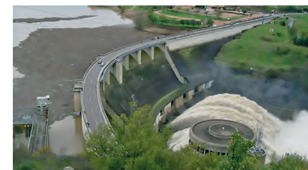
Barrage de Villerest en novembre 2008 (fleuve Loire) © DREAL Centre
